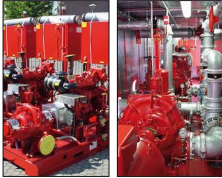
Насосы двухстороннего входа являются "сердцем" многих установок пожаротушения компании "Пентейр Нейхаус". Установки пожаротушения могут быть с электрическим мотором и дизельным двигателем, комплектоваться всей необходимой арматурой и приборами управления согласно принятым нормам и стандартам, поставляться "под ключ" для монтажа в машинном зале или размещаться в специальных контейнерах.
